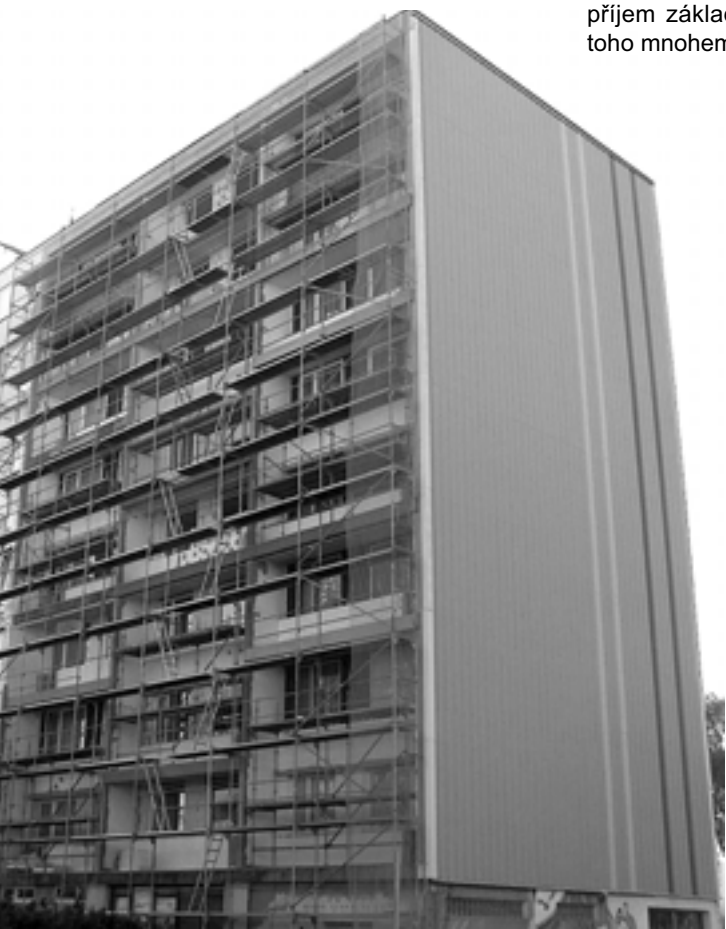
Objekt K 128 v průběhu rekonstrukčních prací
