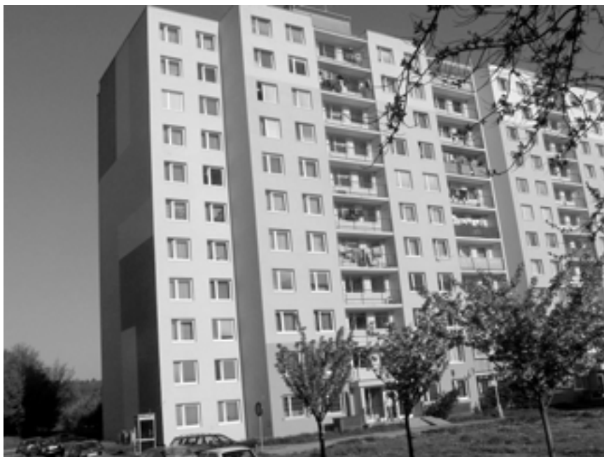
Objekt RS 12 je jedním z domů, kde bylo provedeno zateplení stěn.
