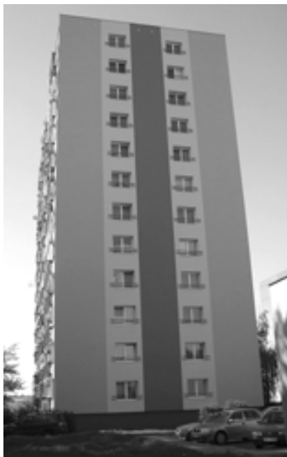
Zateplení štítu na objektu K 313
