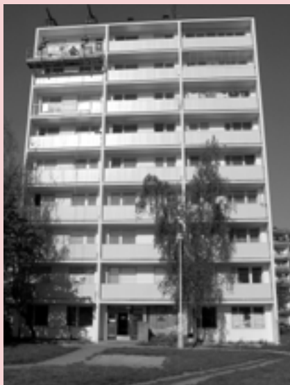
Na panelovém domě MS 12 byla provedena GO lodžii.
