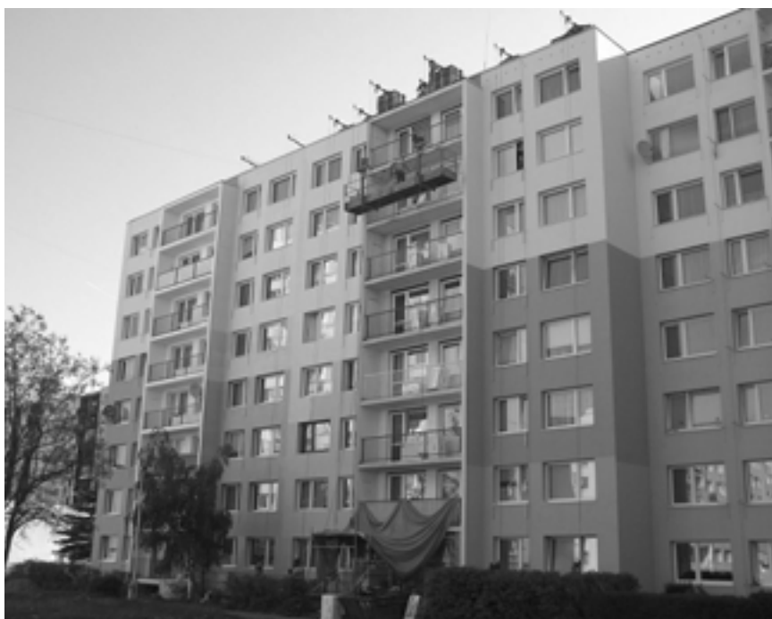
Na objektu K 413 bylo provedeno zateplení stěn.
